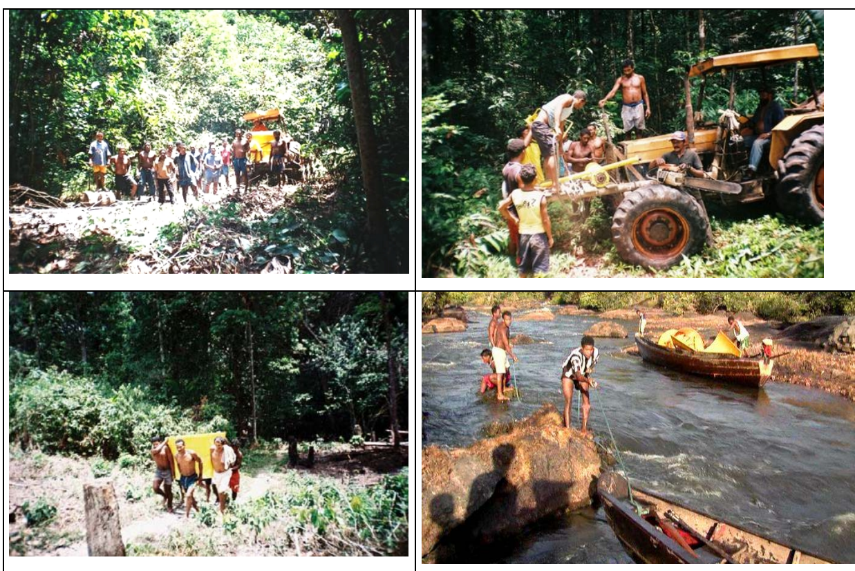
Figura 38 - Mutirão para transportar os equipamentos pelo ramal e rio
