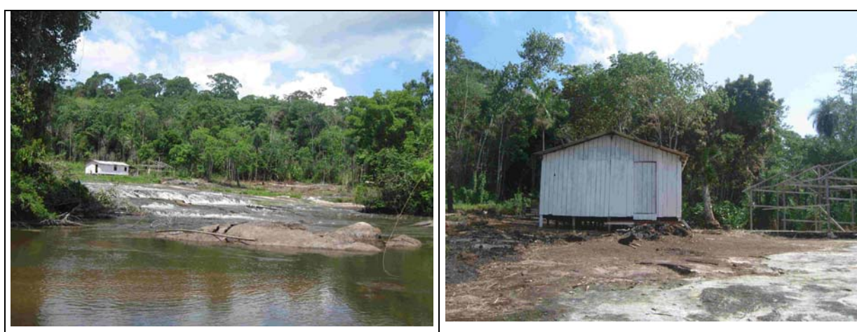
Figura 40 - Barracão da Atexma reformado em novembro de 2006 Fonte: Acervo fotográfico dos projetos Poraquê e Maracastanha
